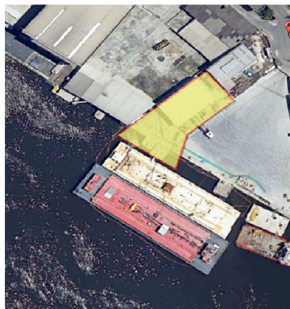
Figura 1 - Instalações da empresa CODEPE.
